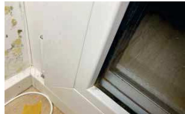
Bild 3 – Fenster und Außenecke im Neubau
