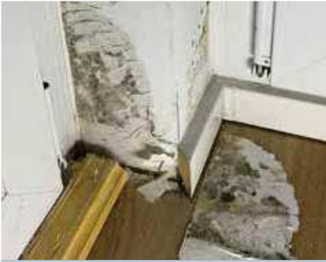
Bild 4 – Detail Außenecke im Neubau
